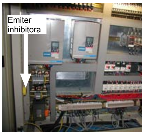
Slika 22: Zaštita elektroničke opreme hlapivim inhibitorima[12]
